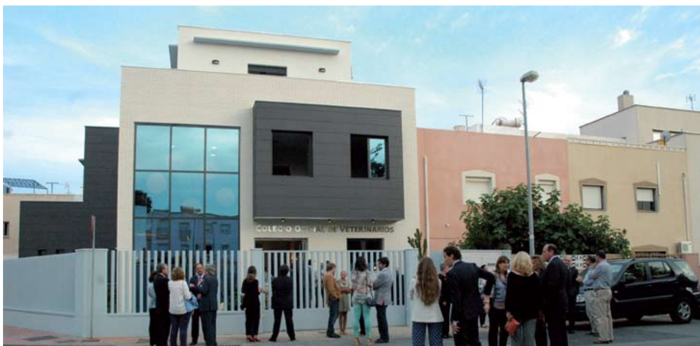
Nuevo edificio de la sede colegial almeriense.
