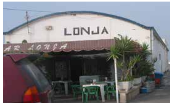
Antigua Lonja de Roquetas de Mar
