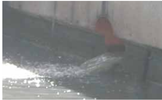
Vertido constante por el aliviadero pluvial del puerto detalle del aliviadero
